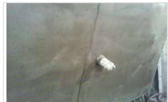
Shotcreting de TUFFCRETE® alisado con llana
