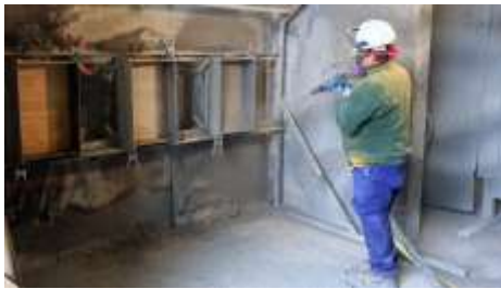
Laboratorio de Guneo/Shotcreting
