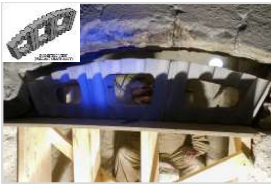
Piezas prefabricadas de METAL-ROK® para el esqueleto del arco de precalentamiento. Permite una efectiva y duradera reparación en sitio por guneo o shotcreting.
