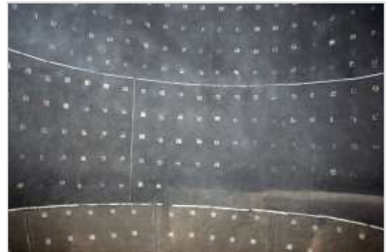
Shotcreting de TUFFCRETE® 60 MZ en el ciclón
