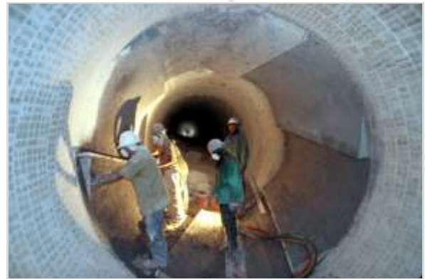
SHOTCRETING en sitio de elevadores
