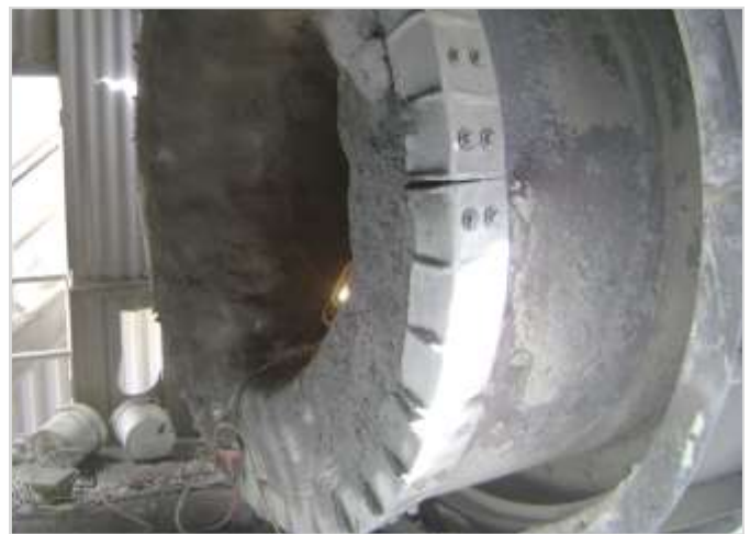
Nariz reparada con guneo de GUNCAST 28 LI
