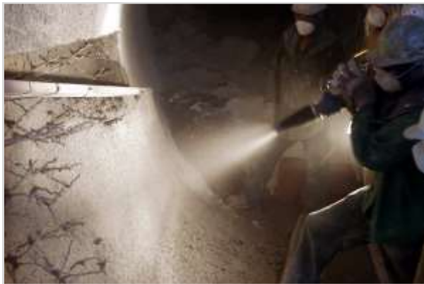
TUFFCRETE 70 ABR shotcreting en alimentacion
