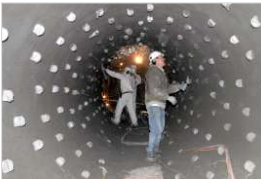
Shotcreting de TUFFCRETE® 65 M en la sección de cadena
