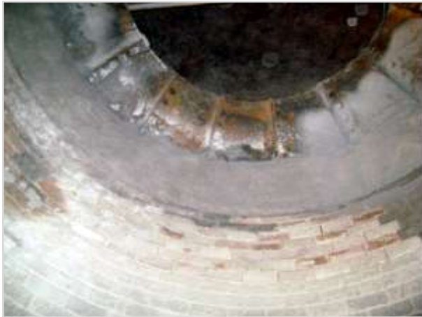
Shotcreting de anillo de cola/salida
