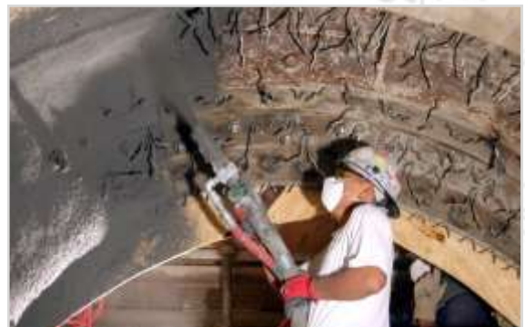
TUFFCRETE® 70 ABR shotcreteados en anillo de salida
