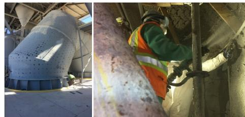
Ducto de circuito shotcreteado con TUFFCRETE® 60 X en la parte superior de la torre. Se utilizaron aprox. 450 pies (137 m) de tubería y manguera desde el piso para llegar hasta la parte alta de la torre.
