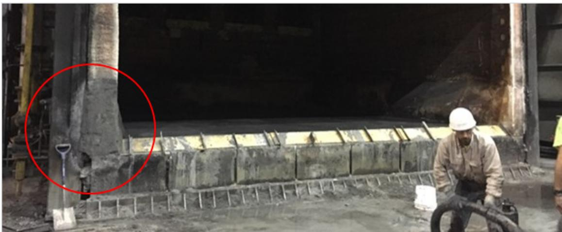
Reparación de pared inferior y marco lateral inferior con hormigón proyectado (shotcrete) TUFFCRETE® 70X
